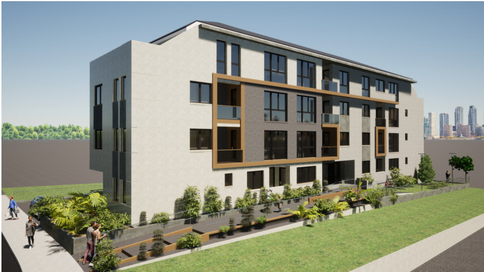
ZAPAD (ulaz za stanare)
